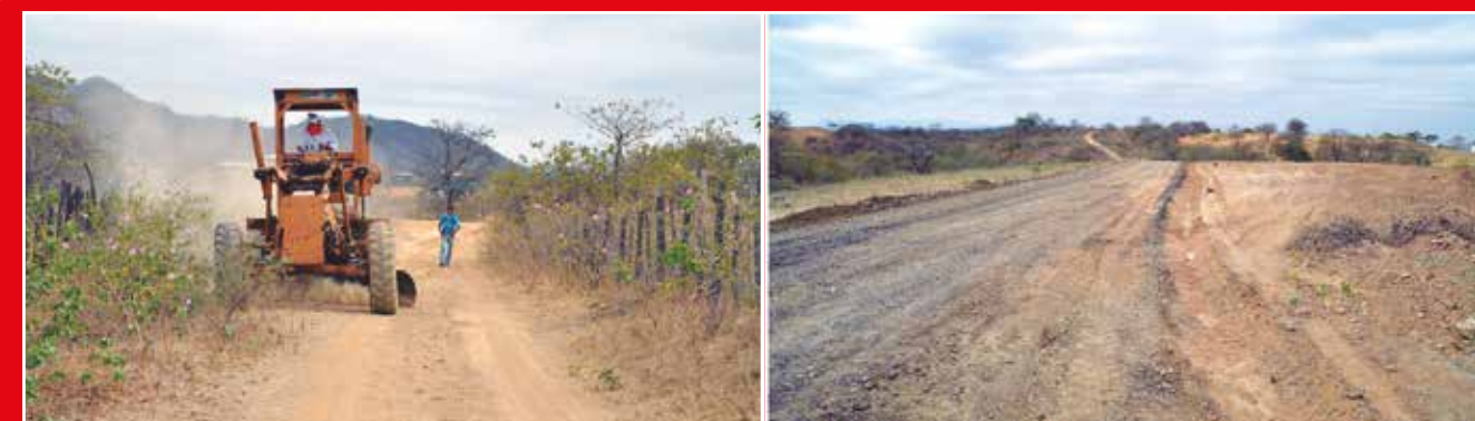
Resanteo, cuneteo y lastrado de la vía de Catamahillo MONTO: $ 1.500
