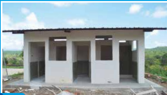
Construcción de batería sanitaria en el barrio Miraflores de la parroquia Mangahurco, cantón Zapotillo MONTO: $ 13.386,85 OBSERVACIONES: OBRA CONTRATADA CON SERVICIO ANTICIPADO PORCENTAJE DE EJECUCIÓN: 95%
