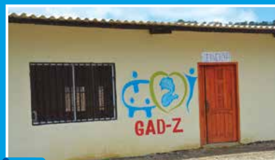
Terminación y remodelación de la Casa Comunal de la parroquia Bolaspamba, cantón Zapotillo, provincia de Loja
