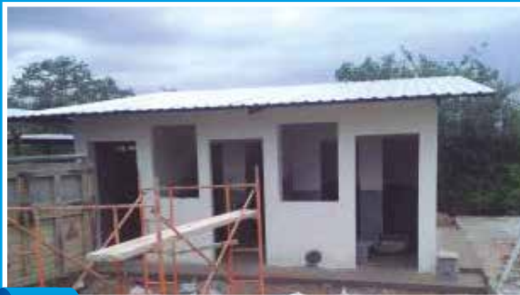
Construcción de batería sanitaria en el barrio Tambillo, parroquia Paletillas, cantón Zapotillo MONTO: $ 13.386,85 PORCENTAJE DE EJECUCIÓN: 85%
